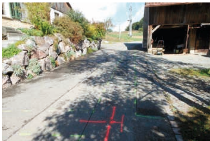
Kehlhof Ersatz Wasserleitung
