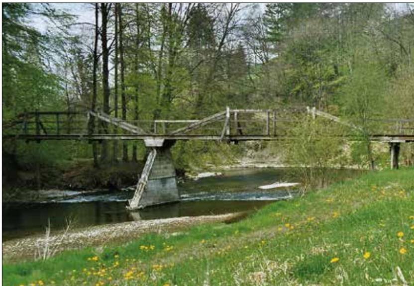
Blinder Steg Baujahr 1991
