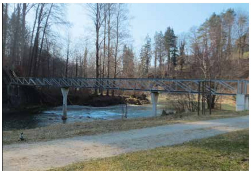
Blinder Steg Baujahr 2010
