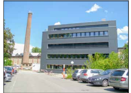
Neues Bürogebäude der Soutec
