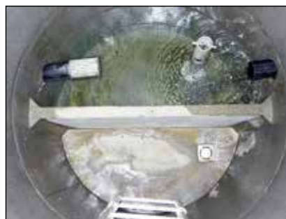
Kristallklares Trinkwasser, Stand der Technik, Verlust behoben- eingelungenes Bauwerk!
