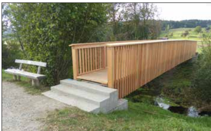
Sanierte Näfbachbrücke BÜTIKOFER-HOLZBAU.CH
