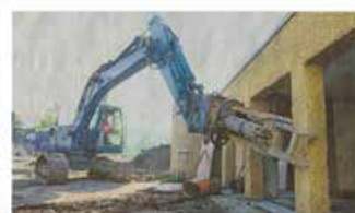
Sepp Manser führt den Betoncrusher vor. Foto: Marc Dürren
