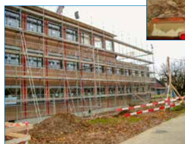
Aufbau der Pavillons in wenigen Tagen
