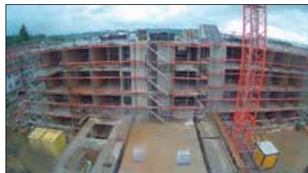
Der Rohbau vom Haus Feld ist erstellt und kann im September 2022 in Betrieb genommen werden (Foto Webcam).
