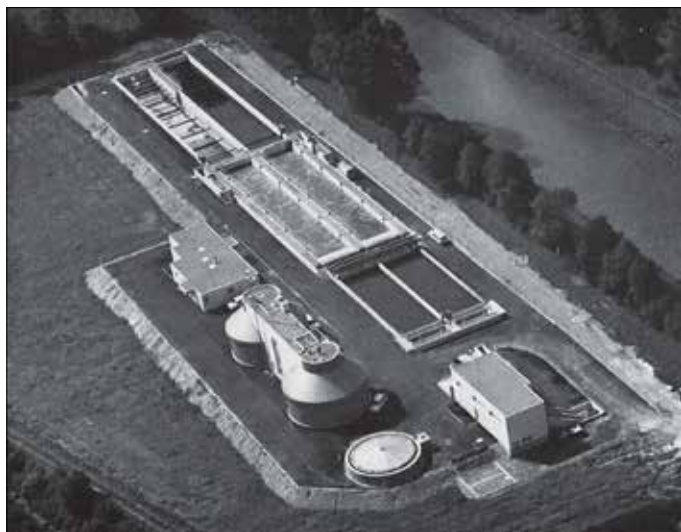
Kläranlage Pfungen bei der Inbetriebsetzung 1973
